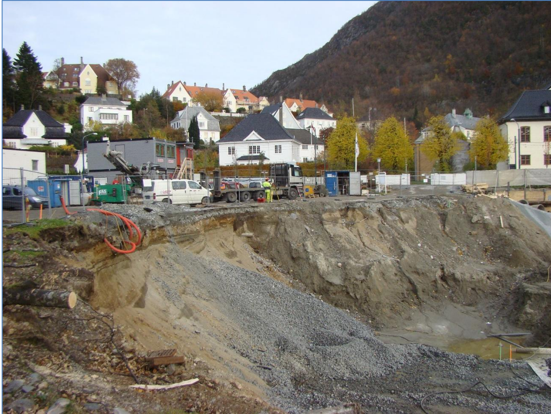
Figur 2. Bilde fra byggegrop for nytt Odontologibygget på Årstadvollen tatt i 2009.
