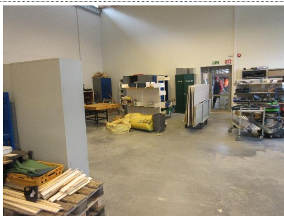
Bilde nr. 13 Verkstedhallen har ubehandlet betonggulv.
