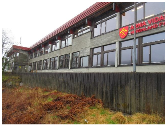
Bilde nr. 1 Deler av vestfasaden.
