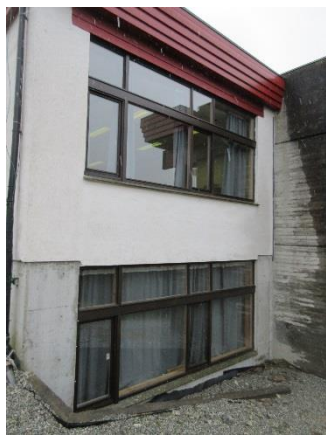
Bilde nr. 3 Liten betonggavl med feil utformet gesimsbeslag samt grunnmursplate som ikke er festet med klemlist øverst.
