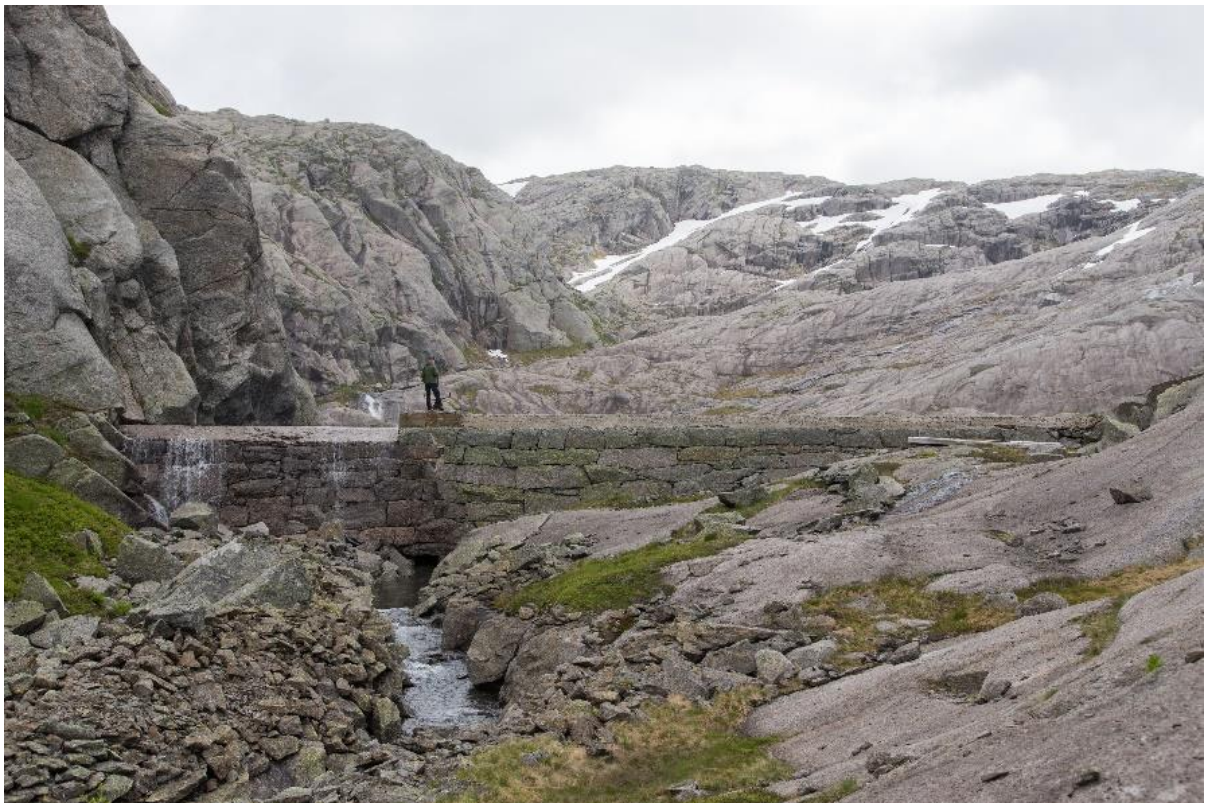
Vetledalsdammen med overløp og kanal. kanal. Foto: Harald Hognerud/NVIM. Arkivnr. VKf-217
