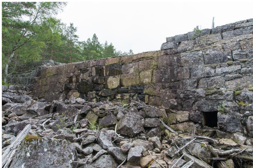
Venstre: Bjørkedalsdammen med ventilhus og start på rørygata med treoverbygg. Høgre: Bjørkedalsdammen sett frå vest, med overløp, tappetunell og steinfylling for forsterking av nordre damfot (1914). Foto: Harald Hognerud/NVIM. Arkivnr. VKf-053 og VKf-049
