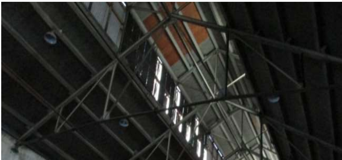
Klerestorievinduerne i dag
