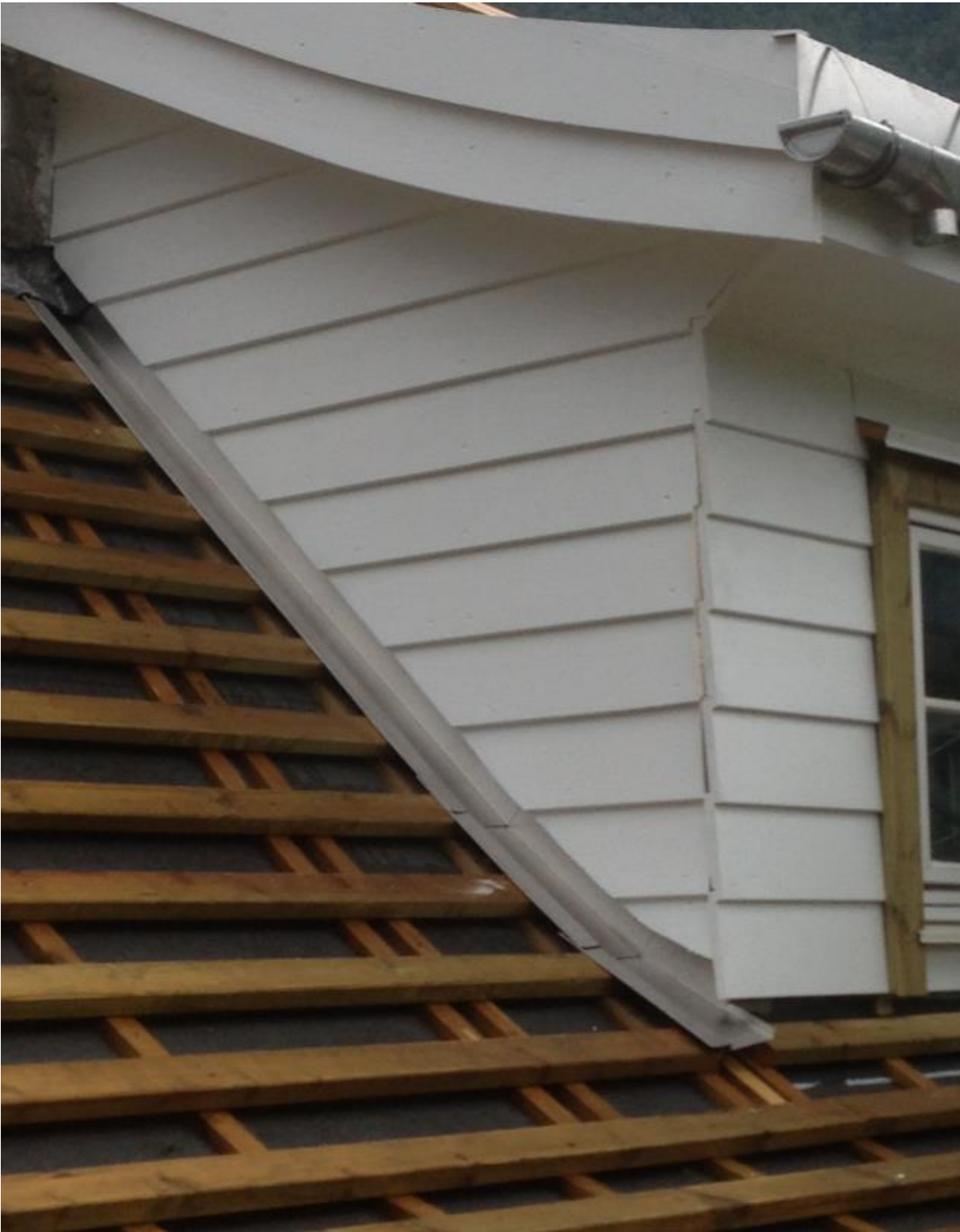
Bord-kledning mot skot-renne.
