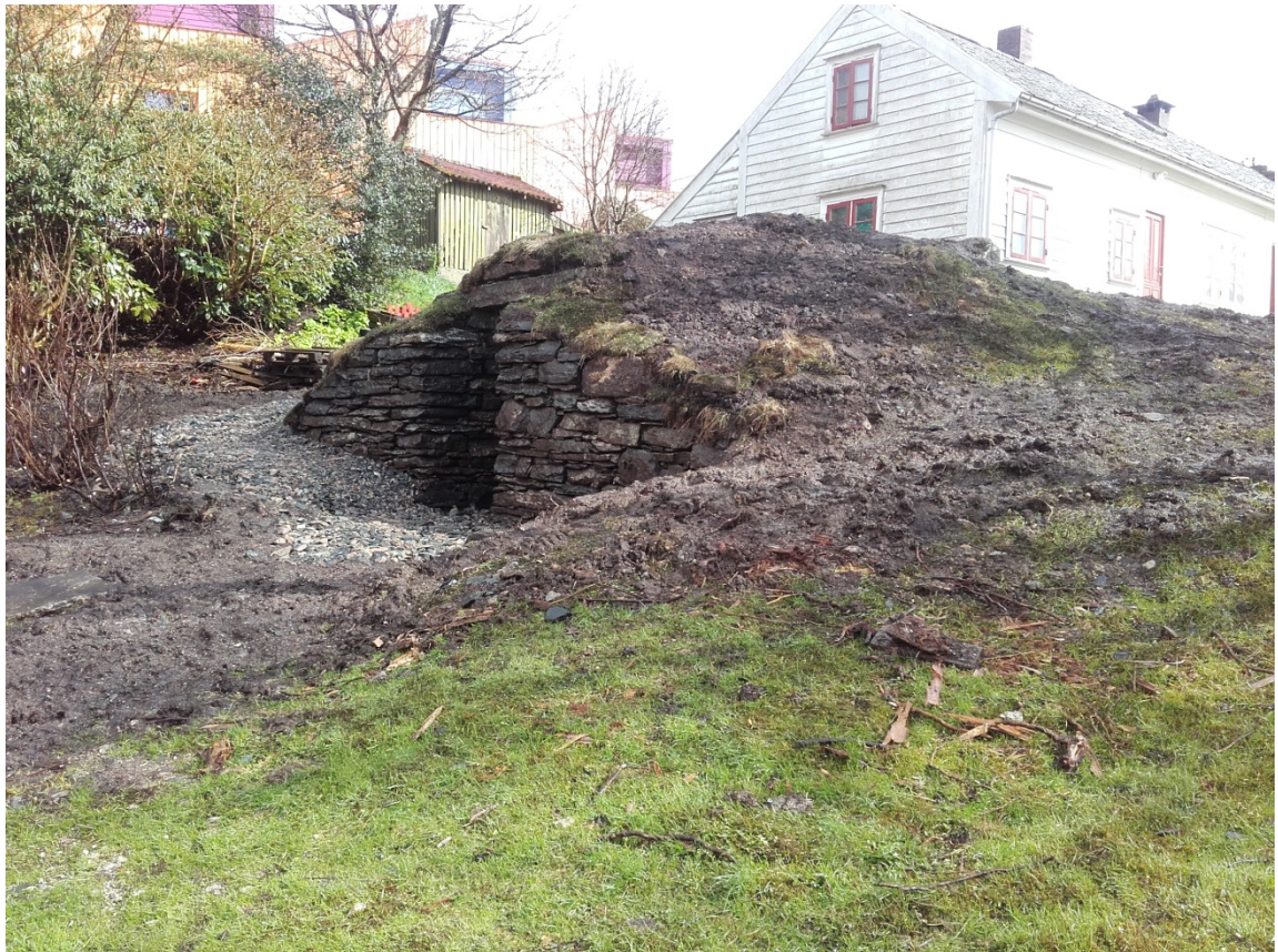
Ferdig! Nå gjenstår bare dør og tilsåing med grasfrø.
