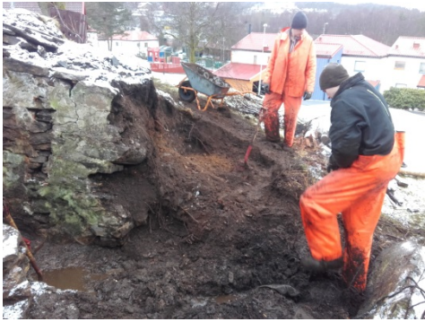
Utgraving for vanger og bakfyll
