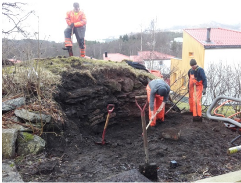
Fjerning av jord
