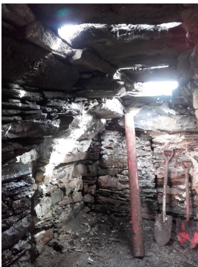
Taket med lufteåpning bortest
