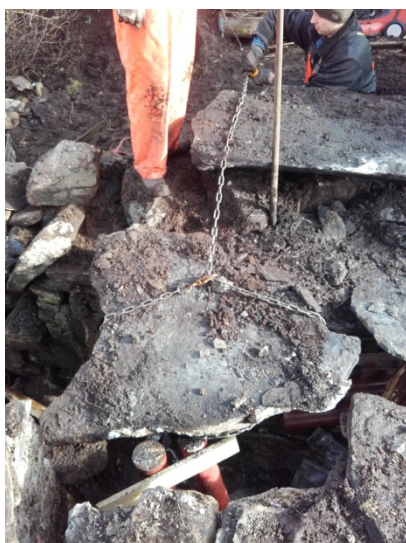
Wirejekk i bruk på tyngre stein
