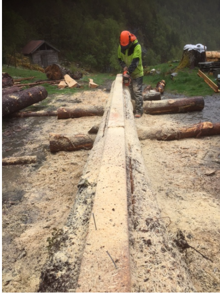
Grovskjæring av laftetømmer
