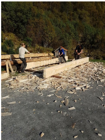
Bearbeiding av laft
