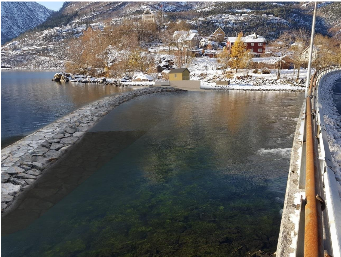
Figur 1 Illustrasjonen viser terskelen ved utløpet Sandvinvatnet/ Opo. Norconsult.
