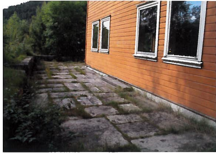
Bildet viser plattingen i sør. Vi ser trappetrinnet som viser hvor døren en gang har stått. Bilde: Byantikvaren.
