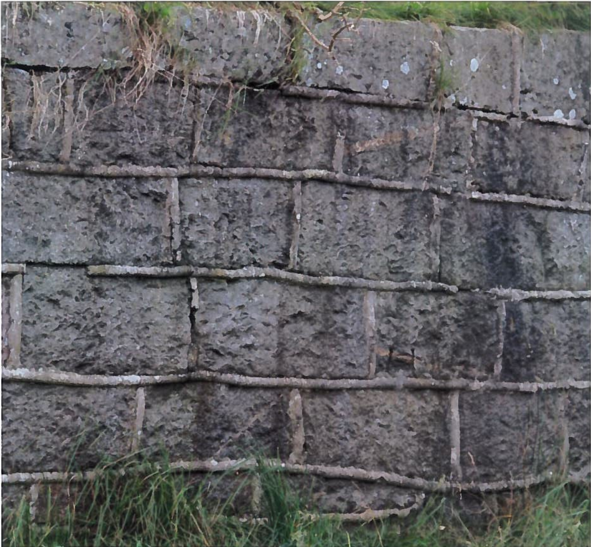
Muren har karakteristiske sementfuger. Bilde: Byantikvaren.
