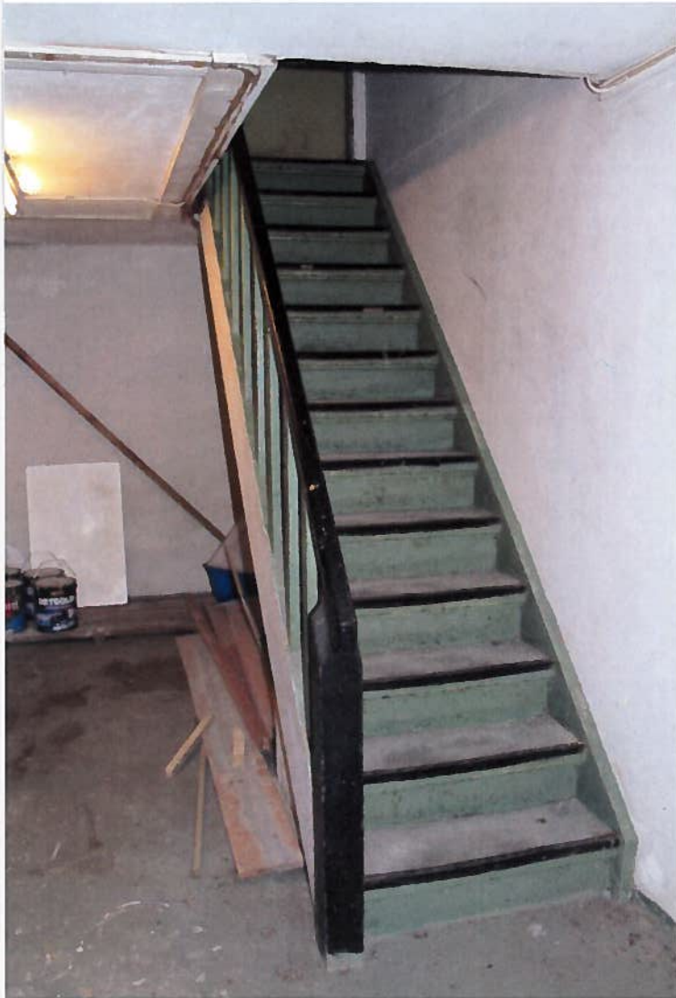
Kjellertrappen er original. Bilde: Byantikvaren.
