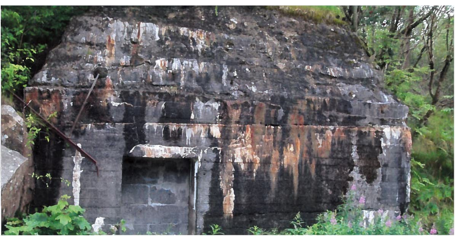
Inngang til bunkertunnel i nord. Bilde: Byantikvaren.
