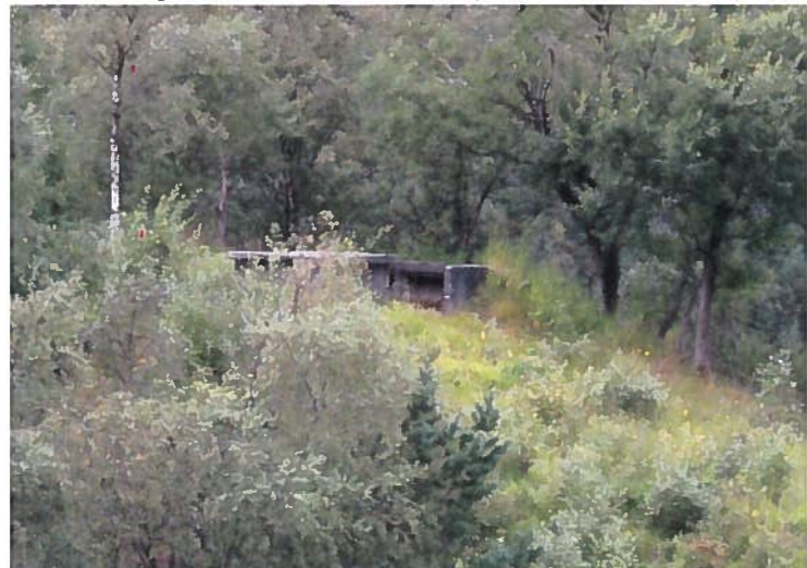
Foto av stillingen for luftvernshyt som ligger lengst vest. Bilde: Byantikvaren.
