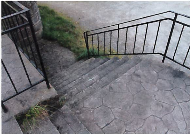
Plattingen ved hovedinngangen er preget av simulert skiferstein og murstein. Bilde: Byantikvaren.
