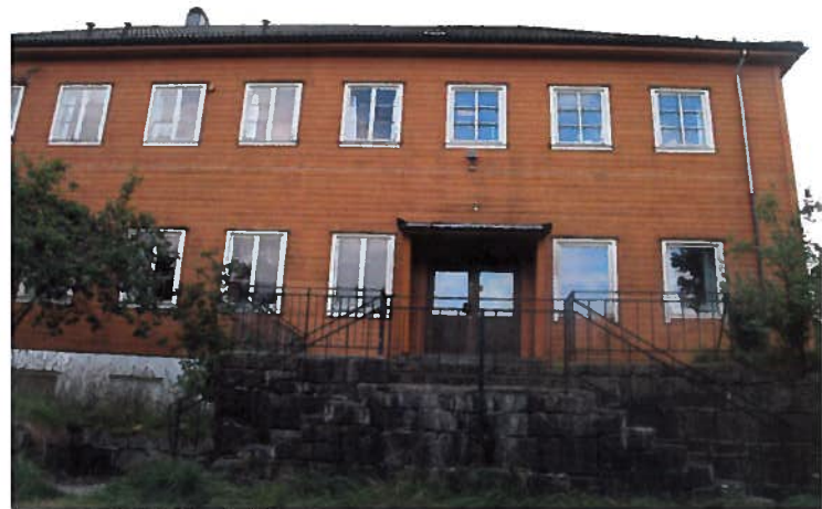
Steinmuren, smijernsgjerdet og dobbeltrappen preger inngangspartiet til Willy Valentinsens vei 34. Bilde: Byantikvaren.
