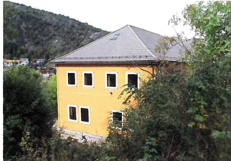
Fasaden i sør uten dør. Bilde: Byantikvaren.
