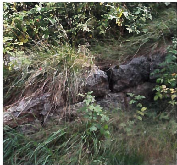
Deler av murverket ligger noe skjult på grunn av tilgroing på tomten. Bilde: Byantikvaren.
