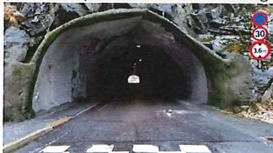
I samråd med Statens vegvesen er det vurdert tiltak. Å skifte lysanlegget er svært dyrt, og i første omgang prøver me tiltak utan å skifte lysanlegg. Det er 12 meter mellom armatura, og det burde i utgangspunktet vere tilstrekkeleg med tiltak som betrar lysforholda med eksisterande anlegg. Der er utarbeidd følgjande opprustingsbudsjett;
