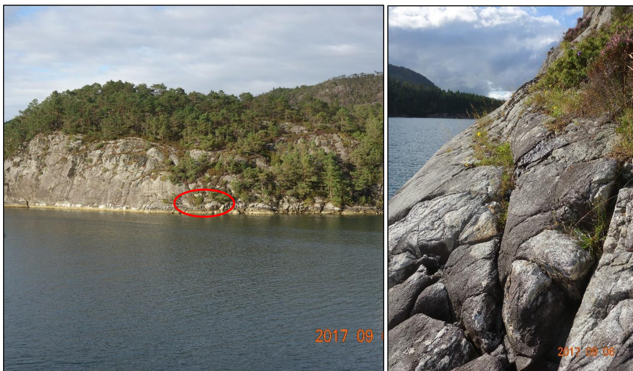
Figur 19: Til venstre: Oversiktsbilde som viser område for planlagt brufeste på Fjelbergøy sett frå Borgundøy. Kartlagt område vist med raud sirkel. Til høgre: Detaljebilde av bergmasse ved sjøen nedanfor brufestet på Fjelbergøy.
