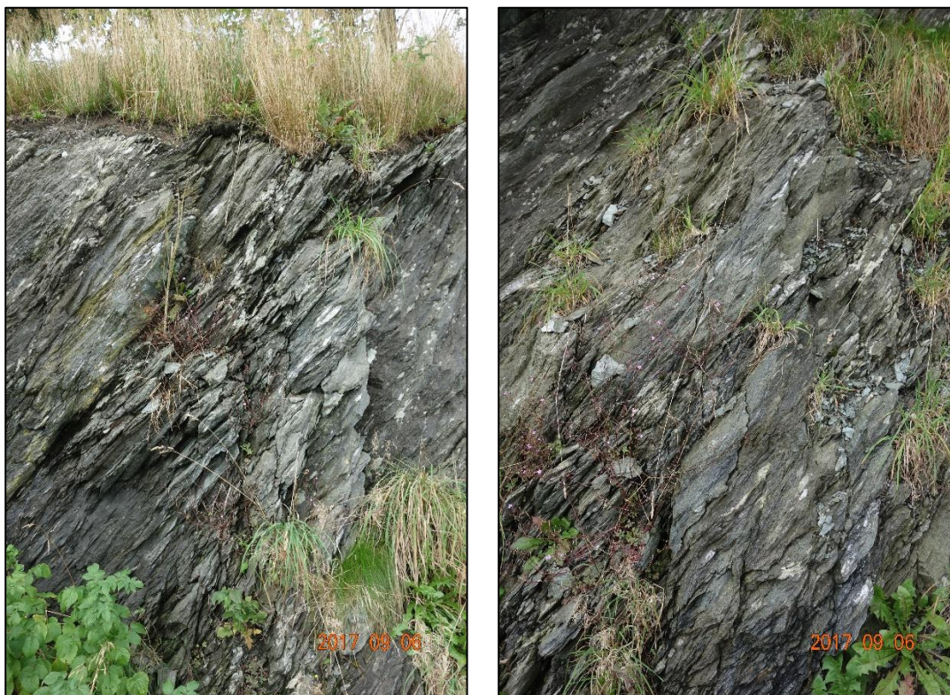
Figur 10: Foto som viser mindre skjeringar i amfibolitt/glimmerskifer langs eksisterande veg, stadvis utteken med gravemaskin.
