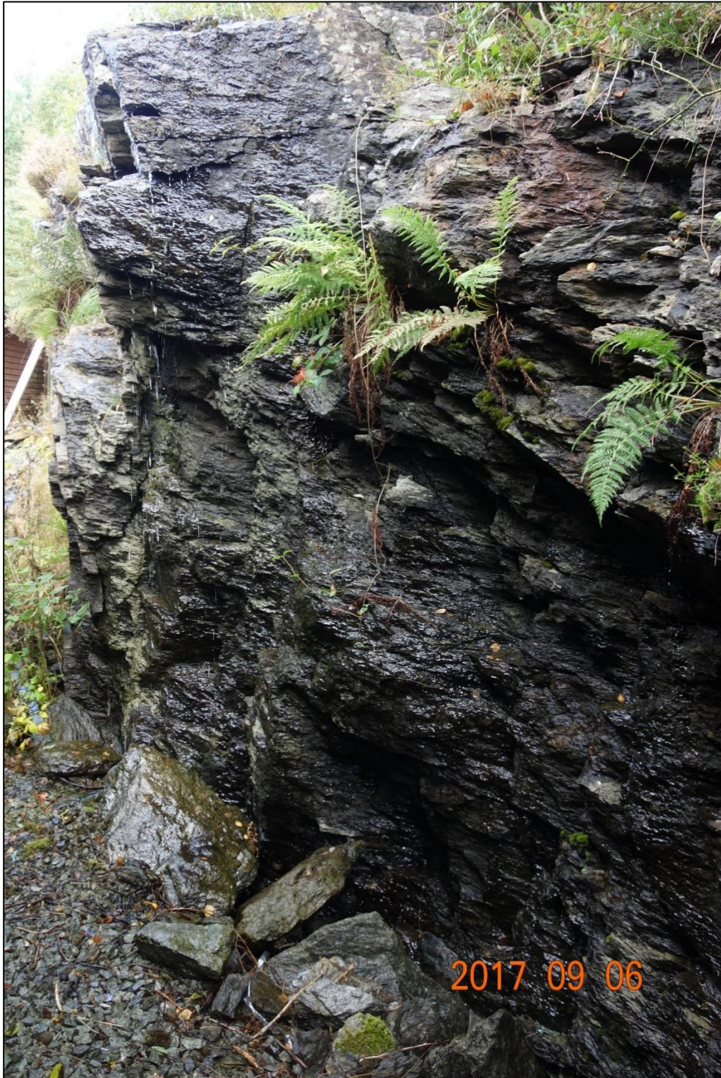
Figur 15: Fyllitt i skjering bak bygning sør for ferjekai ved Sundnes.
