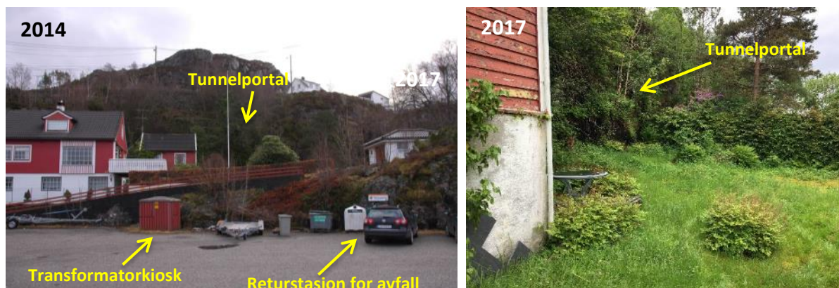
Figur 4-2 a) Bilde av den undersøkte parkeringsplassen i Hetlevik med transformertorkiosken og returstasjonen for avfall. Bildet er tatt mot sørøst, og viser området der tunnelportalen vil gå inn i fjellet. Bildet er hentet fra KU-rapporten for Fv212 Slettebrekka – Hetlevik. b) Bilde fra hagen i Hetlevikvegen 82, hvor tunnelportalen skal komme ut. Bildet er tatt i sydlig retning, (foto: ISS).
