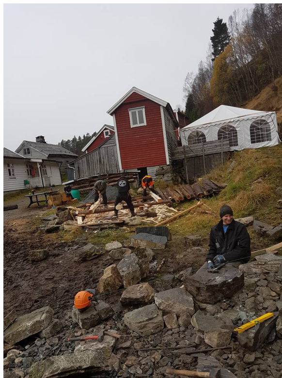
Muring av tørrmur (har ikke bilde av ferdig mur akkurat nå).
