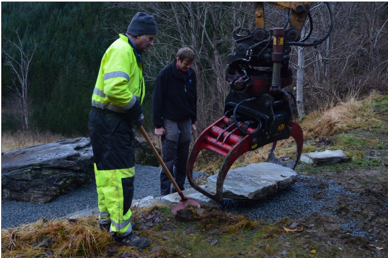
Ferdigstilling av trapp. Foto: HFK
