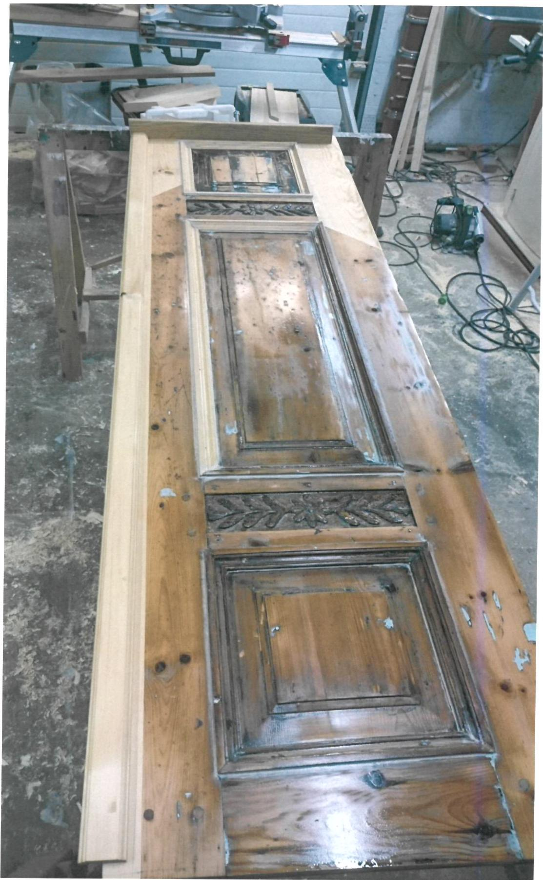
Under sluttmonteringen ble de originale hengslene montert. De var skadet og rullene på hengslene var kuttet av. Det var fra før moderne hengsler på døren som vi valgte vekk til fordel for de originale. Her har vi fått en smed (Askøy Mekaniske AS) til å lage nye ruller og satt på igjen de originale hengslene.
