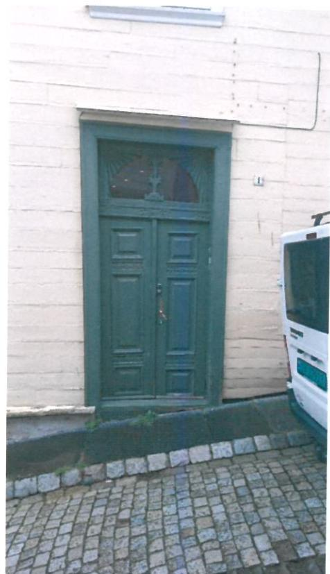
Døren har store råteskader i nederste rammtre og fyllingene. Råteskaden strekker seg ca. 50cm oppover. På grunn av montering av div. låskasser er rammen på selve døren blitt instabil. Jeg velger å erstatte den delen der alle låsene tidligere har vært montert, med nytt treverk. Døren har før vært flikket med lite suksess, og er i disse områdene blitt svekket. Delene som har blitt reparert virker løse og vridde.
