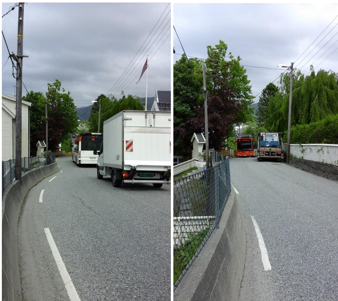
Figur 11: Fyllingsvegen er så smal at to tyngre kjøretøy ikke kan møtes, og mangler fortau til gående og syklende på strekningen.
