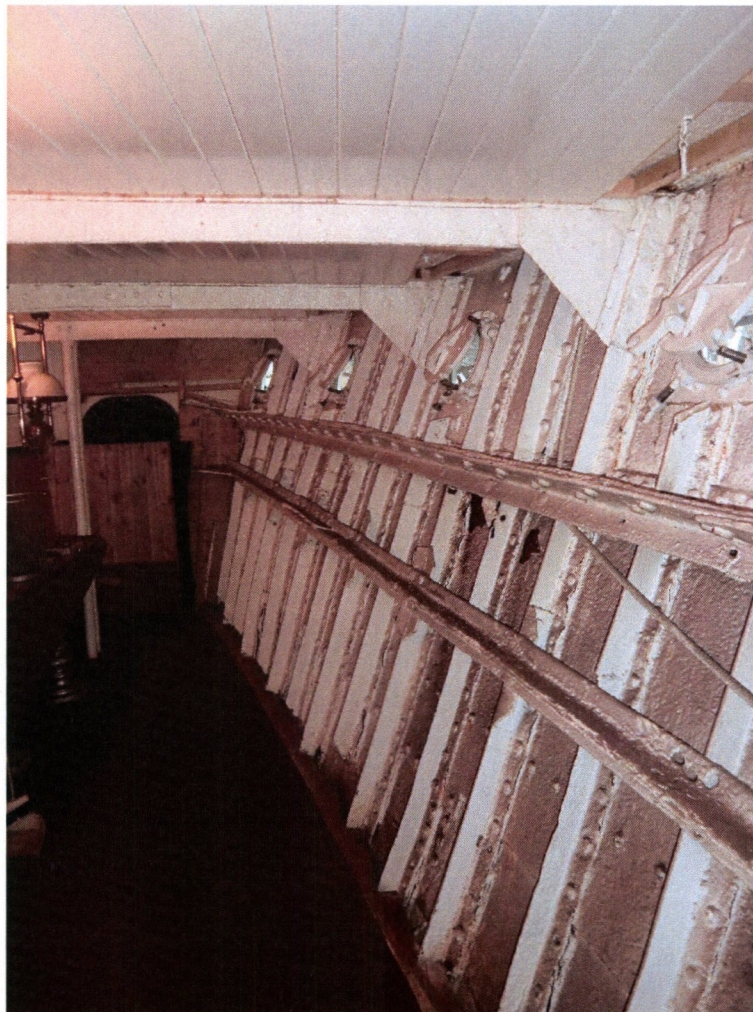
Reparasjon av stål i SB skuteside i forut 2 klasse salong
