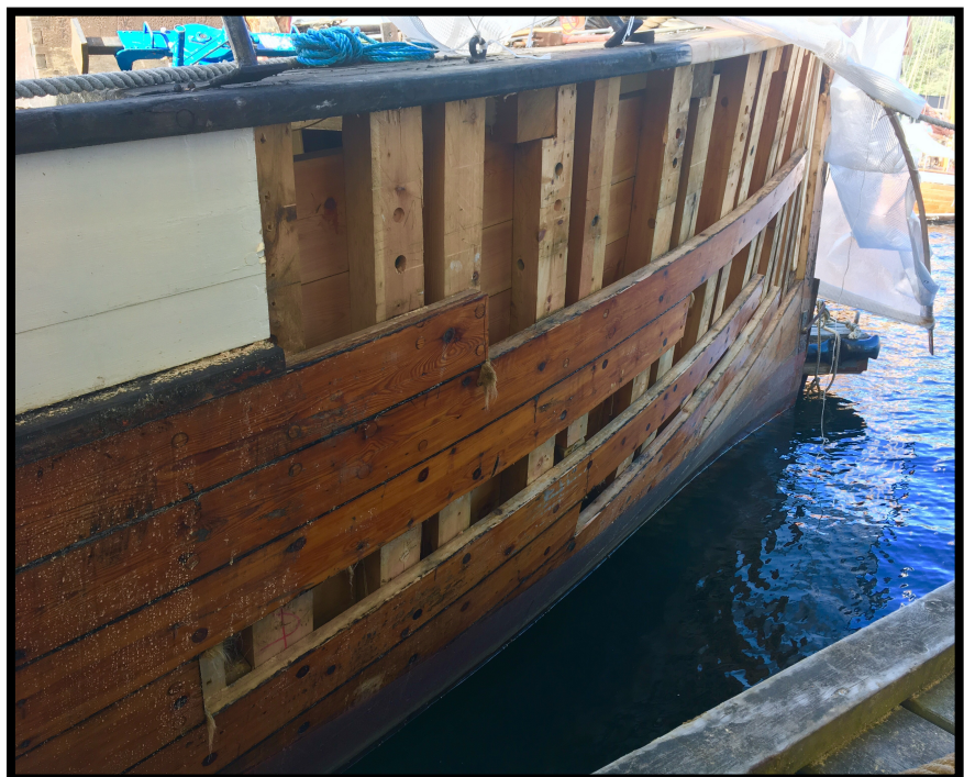
Klar for ny hud og skanseledning
