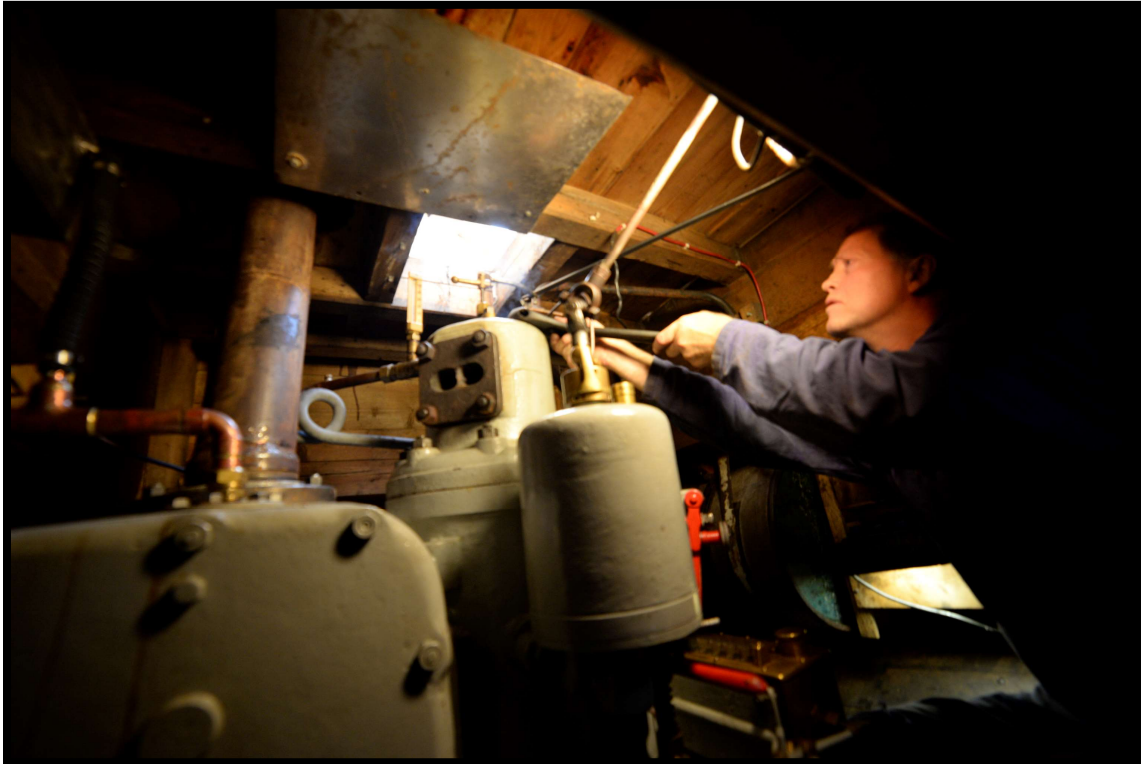
Svein fikser lekkasje ved glødepluggen før oppstart
