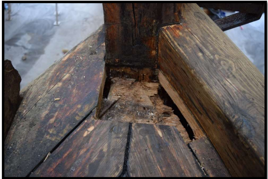
Bilde viser området i stevnen som ble midlertidig reparert i 2015
