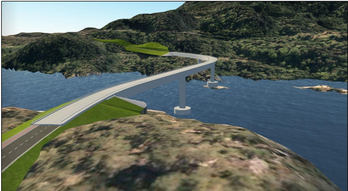
Figur 12: Bru over Nordre Fjelbergsund, sett frå Fjelbergøy mot Borgundøy.
