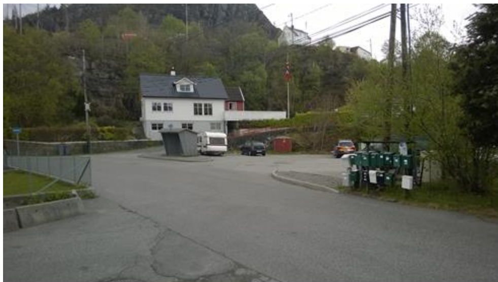
Figur 1.2 Hetlevik ved den fremtidige vestportal og rundkørsel
