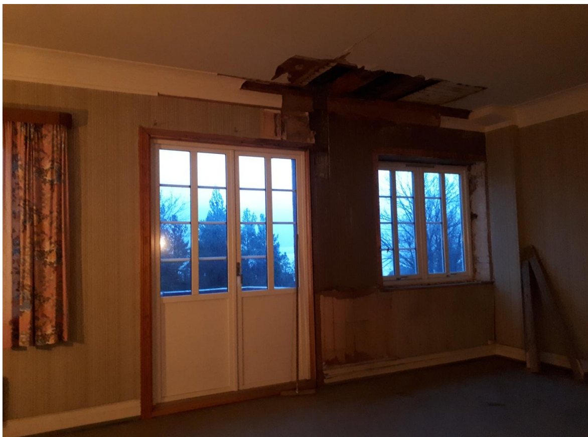
Riving etter vatnskade i salong/allrom.
