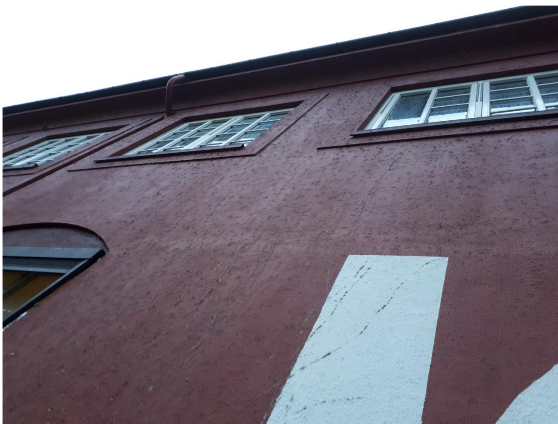
Rester av eføy som sete "limt fast" i veggen på eine fasadesida.
