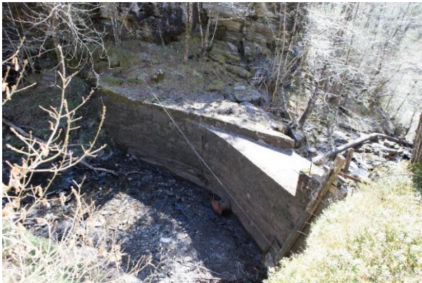
Betong på innsida og tørrmur på luftsida. Røyrgjennomføring i midten. Foto: Dag Endre Opedal, NVIM
