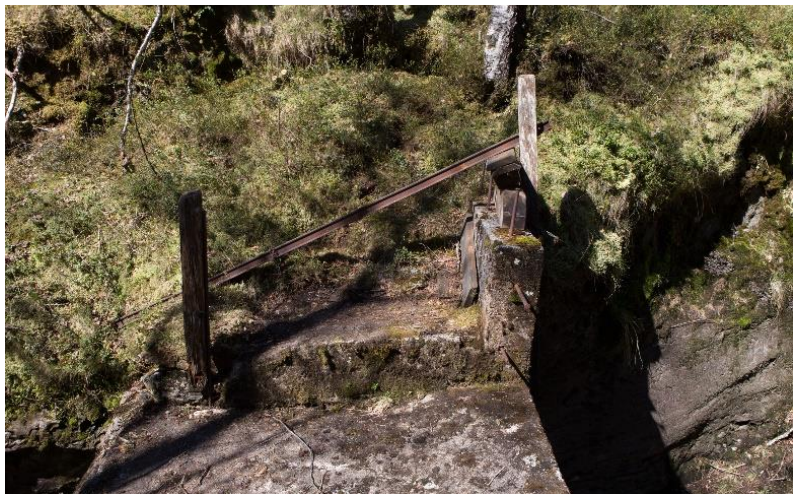
Stengeanordning røyrgate og tømmluke. Tømmluka er plassert på eine sida med løfteanordning. Foto: Dag Endre Opedal/NVIM
