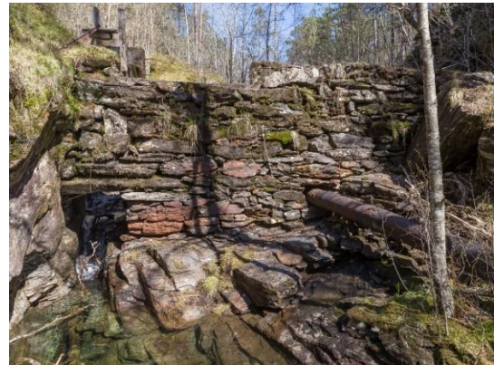
Betong på innsida og tørrmur på luftsida. Røyrgjennomføring i midten. Foto: Dag Endre Opedal, NVIM
