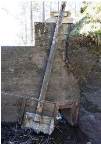
Stengeanordning røyrgate og tømmeuke. Tømmeluka er plassert på eine sida med løfteanordning. Foto: Dag Endre Opedal/NVIM
