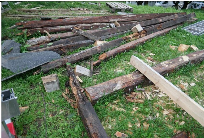
Råte sperr som er skifta ut
