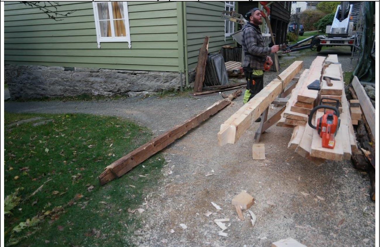
Foto over viser råte sperr, under er ny sperr kopiert lik den gamle
