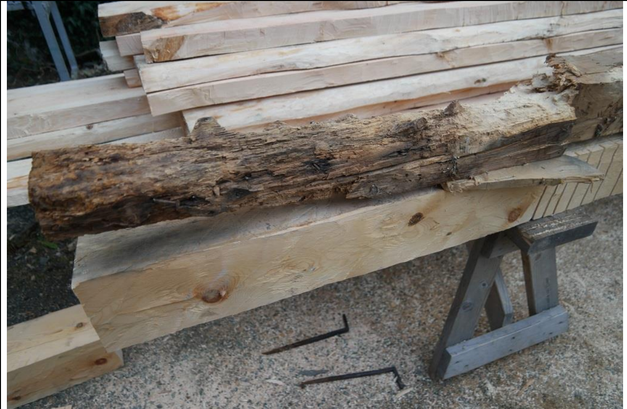
Foto over viser råte sperr, under er ny sperr kopiert lik den gamle
