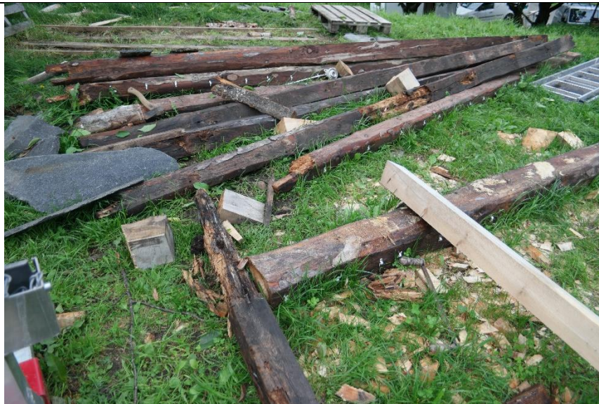
Råte sperr som er skifta ut
