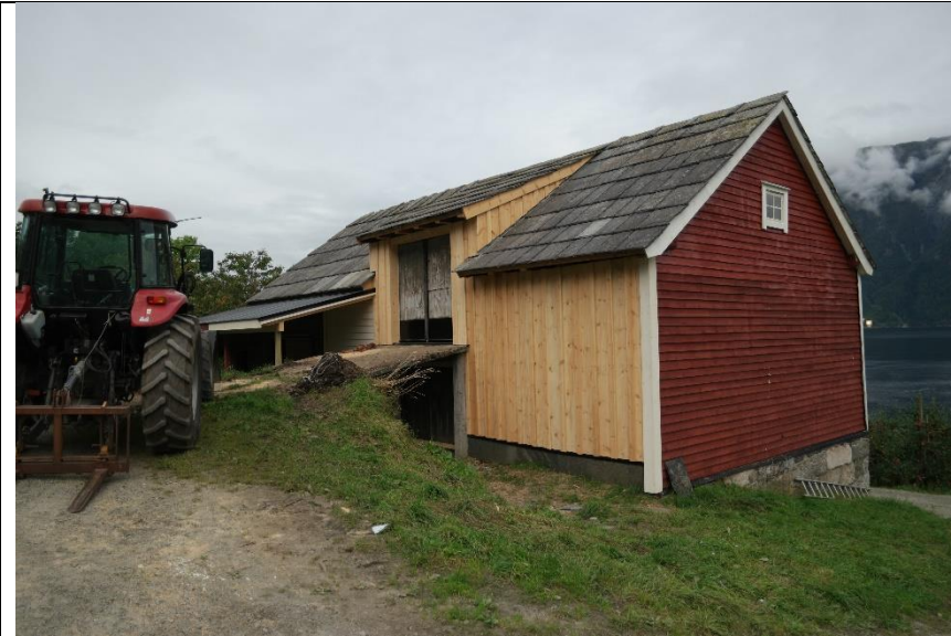
Noko kledning er skifta
