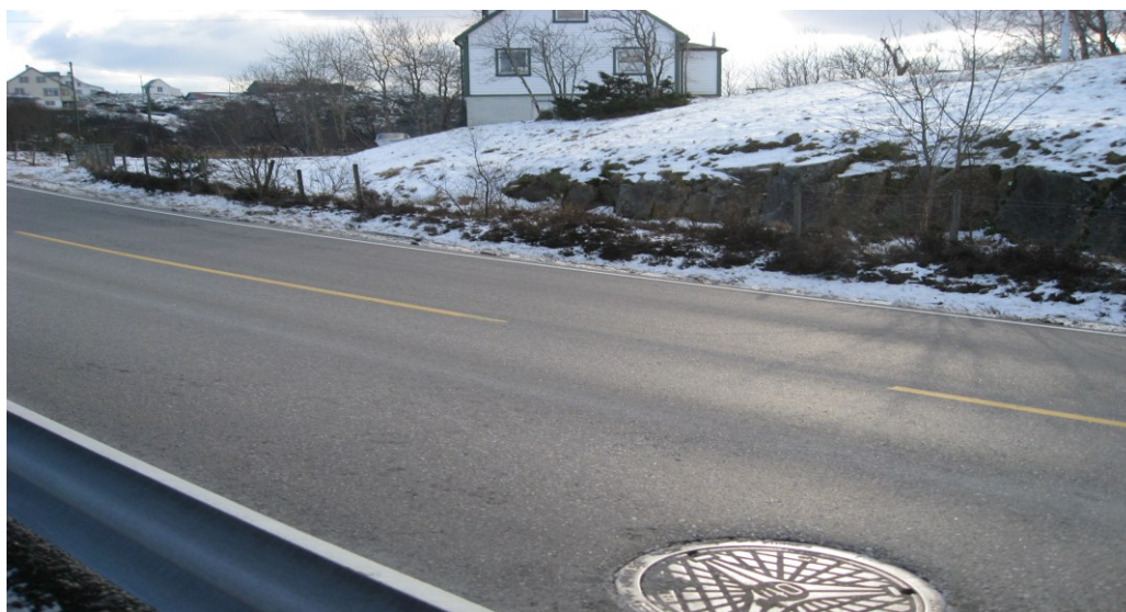
Kumlokk med låg kant på Blom som er farleg for syklar og mopedar. Er utbetra.
