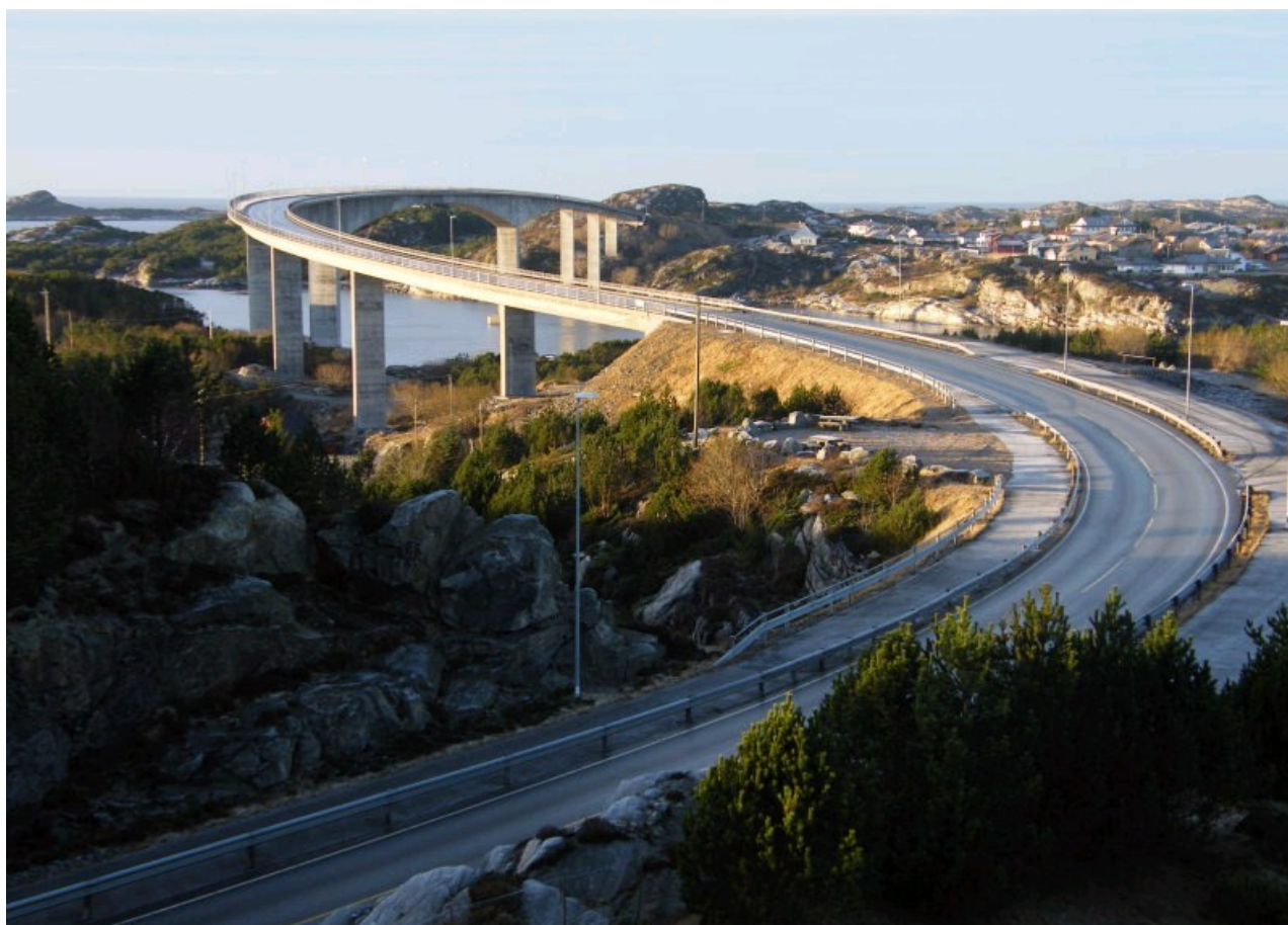
Rongesundet bru – mellom Toftøy og Rongøy. Den største og lengste brua i kommunen og innfallsporten til resten av Øygarden nord for Toftøy. Foto: Øygarden kommune.
