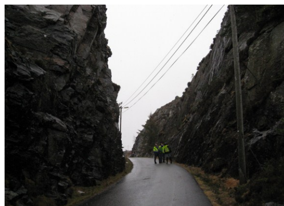
Garholet ved Breivik – fare for steinsprang
