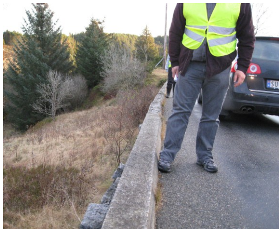
Låg / forskuva støypekant på Sturevegen
