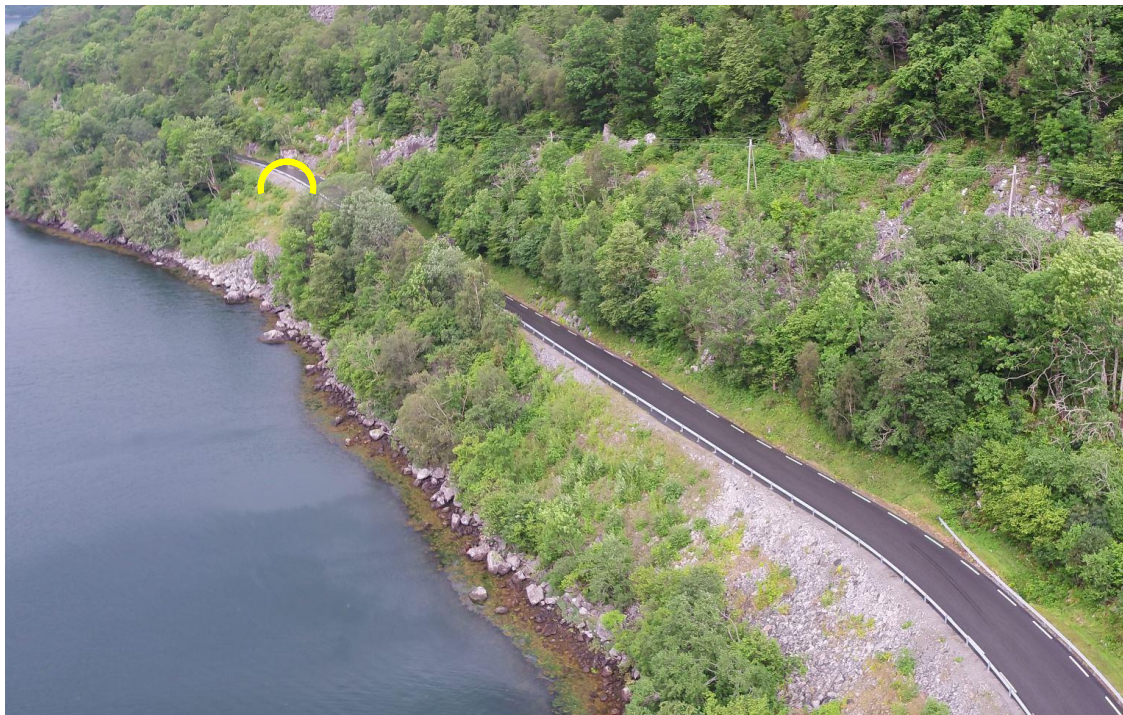
Figur 11. Skissert plassering av påhogg E (innslaget må vere såpass ned i terrenget for å få tilstrekkeleg med bergoverdekning for påhogg som skal vere i kant av dagens veg).
