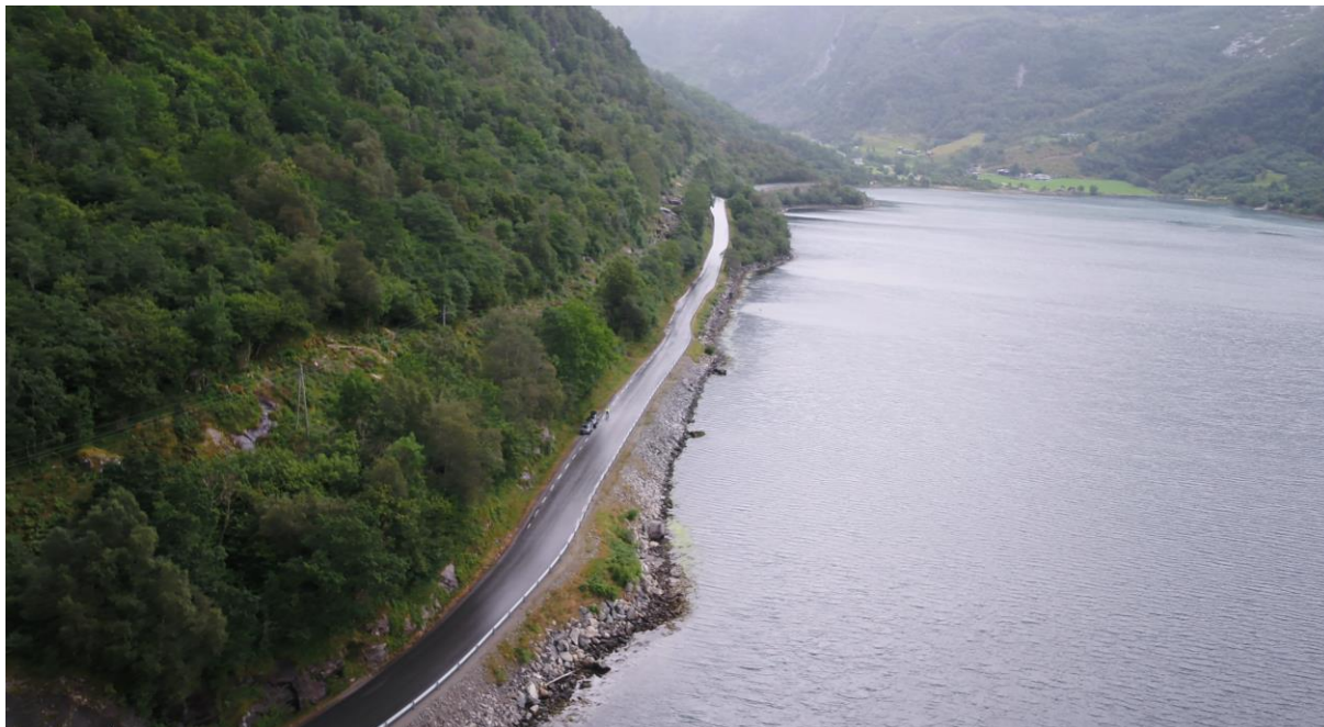
Figur 21: Fylling i sjø er naudsynt i linje 3 for å oppgradere vegen innover mot Austrepollen.
