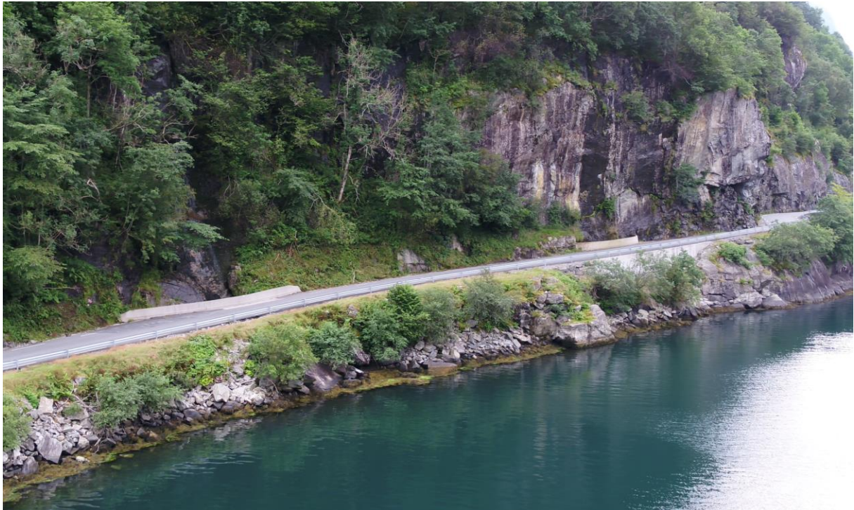
Figur 5: Med fjorden djup ned og fjellet stupbratt opp er det ikkje lett å etablere ny sikker veg på strekningen.
