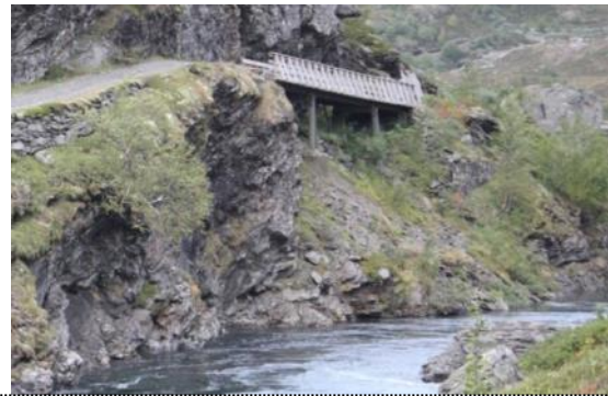
Th: Bru til erstatning av utrasa mur.
