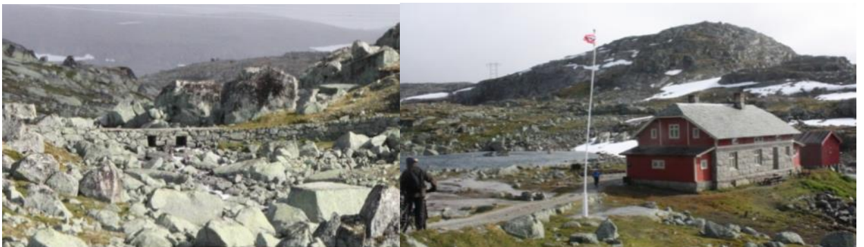
Tv: Ved Fagernut. Opprinneleg mur med intakte stikkrenner . Th: Fagernut vaktarbustad.
