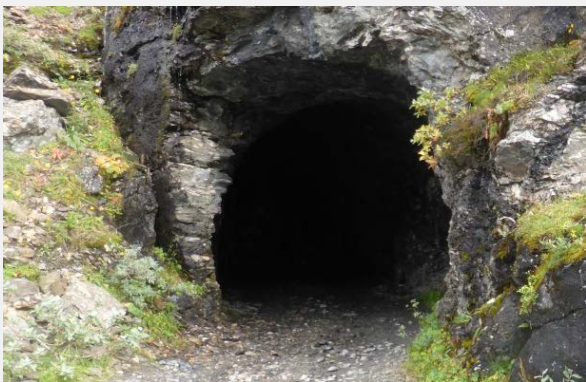
Element nr. 20 Vegtunnel Kleven
