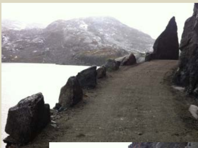
Element nr. 16: Mur ved Høgda
