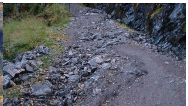
Th: Før rehabilitering.
