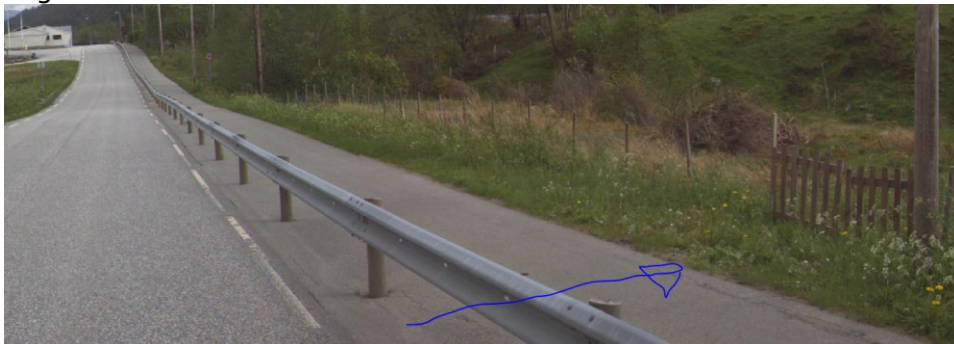
Grinda i gjerdet ved omsøkt avkørsel. Retning mot Samnanger.
