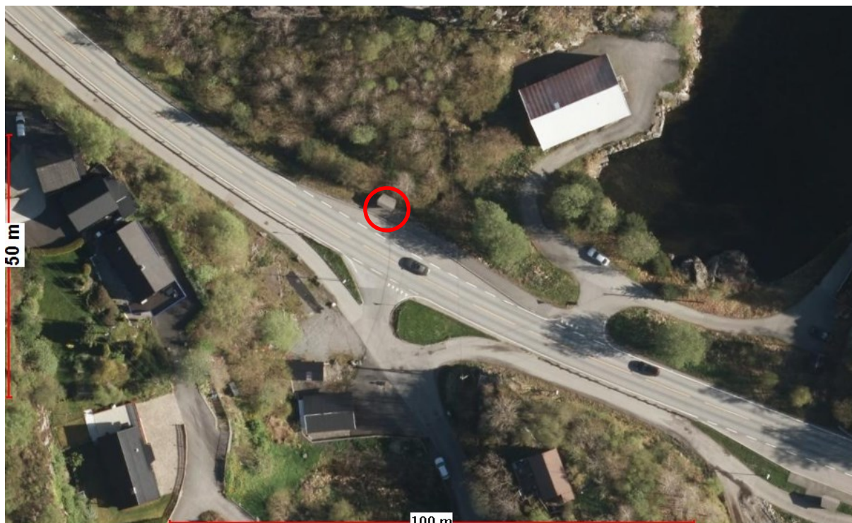
Bilde 4. Ortofoto som viser kryssområdets utforming i dag. Manglande tilbud for myke trafikantar som skal krysse 60 sone ved busshaldeplass. ÅDT = 10 900 (2016). Pr. i dag har nokon få eigedomar aust for krysset køyretilkomst via gang- og sykkelveg.
