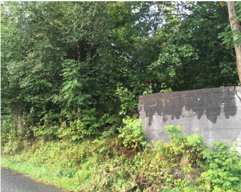
Figur 39. Etableringen av Vilhelms Bjerknesvei har skapt en høydeforskjell til gamle Slettebakksvei. Det er satt opp en betongmur der veien en gang kom ned. Det er fylt inntil muren i bakkant med grove masser. Til venstre for betongmuren ses det siste lindetreet i rekken av 15.
