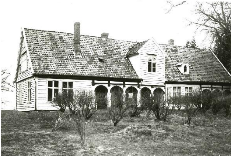
Figur 11. Eldste kjente foto av fasaden mot sør. Bildet er udatert antakelig fra perioden 1890 til 1910. Lauritz Bekker Larsen. Billedsamlingen UiB.
