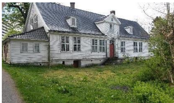
Hovedhuset, fasade mot nord.
