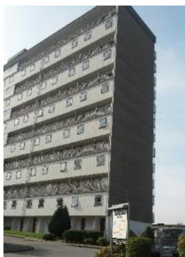
Blokkbebyggelse på tilgrensende eiendom på 13 etasjer.
