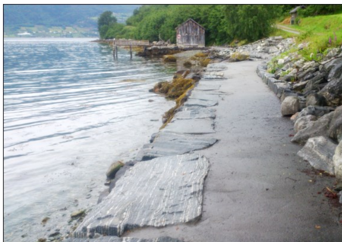
Figur 21. Eksempel på kaikonstruksjon opparbeidet med formål å etablere badeplass / oppholdsareal langs en vegkant. Dalsbygda i Norddal.
