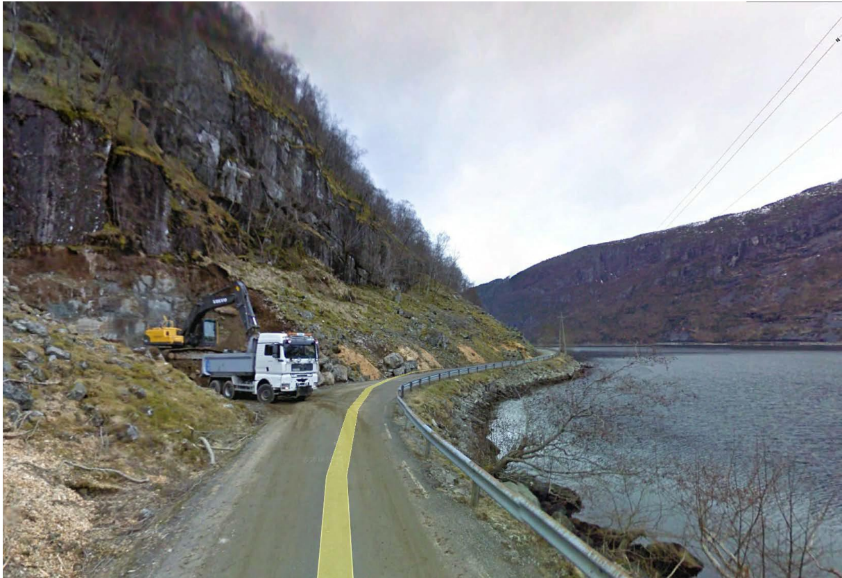
Tunnelpåhogg Nordrepollen der gravemaskin synes i bildet
