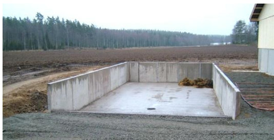
Bilde 3 En gjødselplate med fall slik at væske fra gjødsel, regnvann m.m. kontrollert kan drenes vekk.
