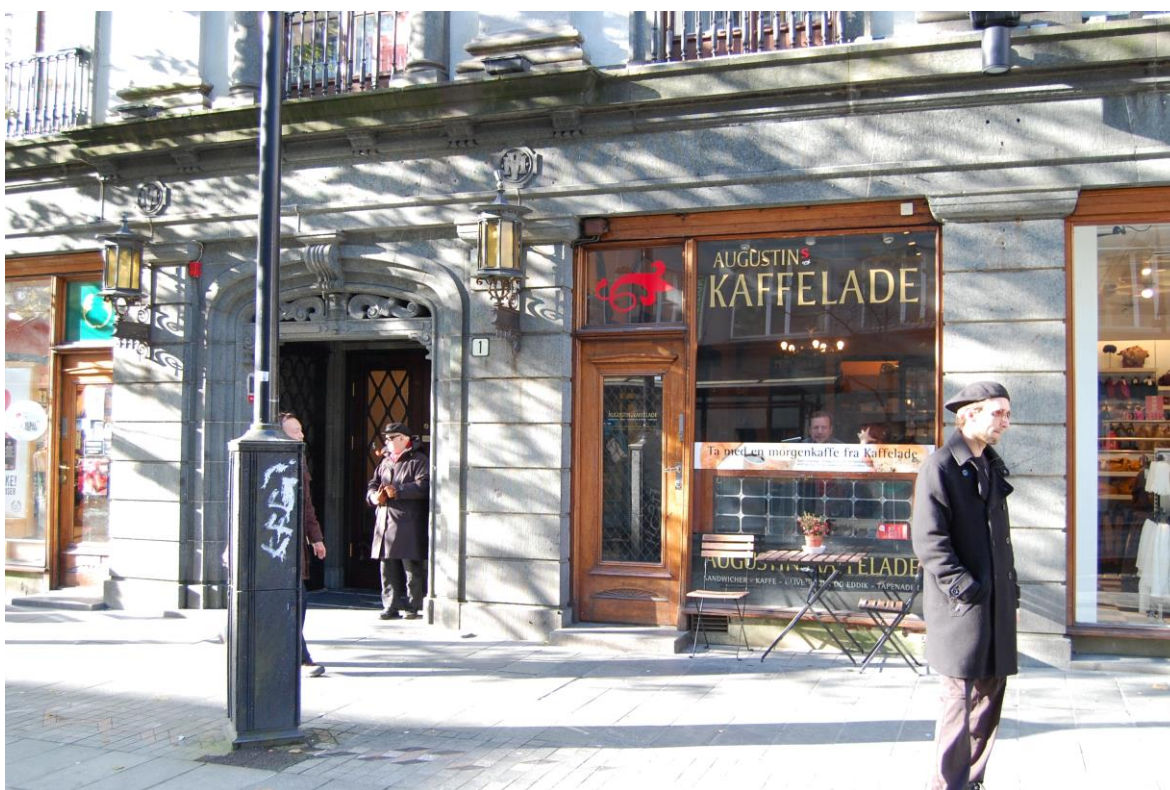
Detalj av fasaden mot Olav Kyrres gate (hovudingang til v., Reimers & Sønns Efft. til h.)
