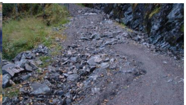
Th: Før rehabilitering.
