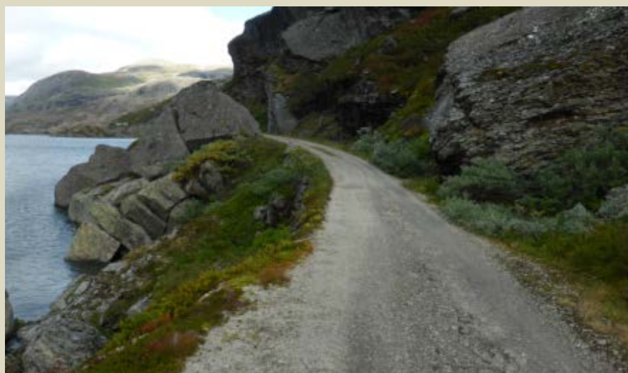
Element nr.20: Hallingskeid-Kleven undergang
