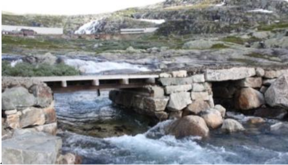
Tv: bru på skjener og hellebru, Hallingskeid.
