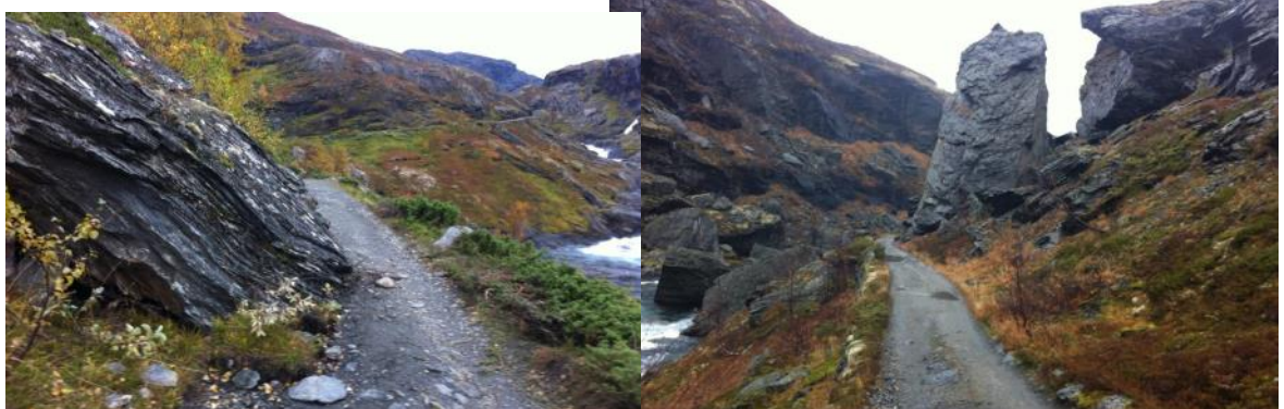
Tv: Klevagjelet. Tv. blokk på sig ned og inn i vegen.
