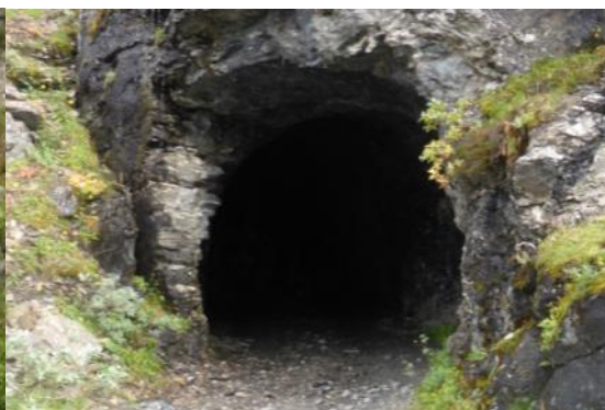
Th: Tunnelen under banen ved Kleven bru
