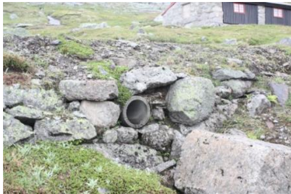
Tv: Døme på kollapsa stikkrenne. Th: Tidlegare nød reparasjon av ei anna.
