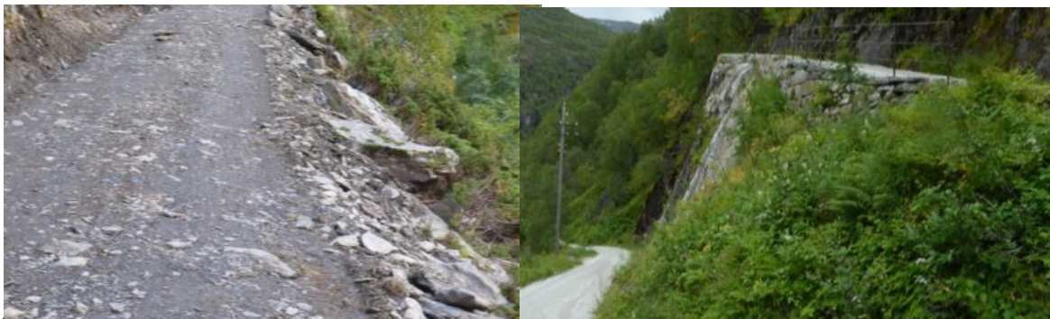
Tv: Mur på skråfjell, fyllitt Klevagjelet. Th: mur med sikring, Myrdalsvingane.
