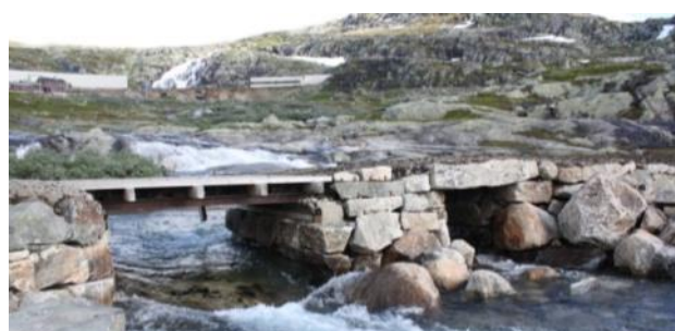
Tv: Mørkaskjeringa – vegen er tidlegare flytta ut og ned på eit lågare nivå. Th: Ved Hallingskeid – hellebru og trebru på iernbaneskiener.
