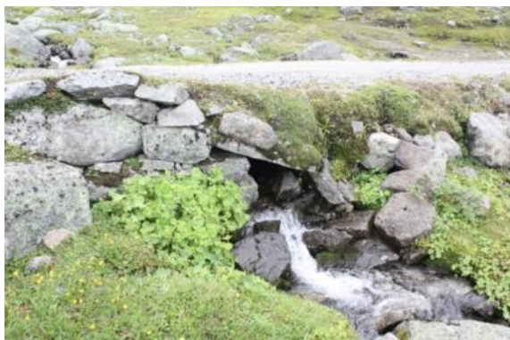
Tv: Døme på kollapsa stikkrenne. Th: Tidlegare nød reparasjon av ei anna.
