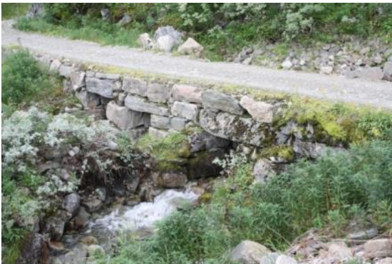
Tv: Rehabiliterert stikkrenne.
