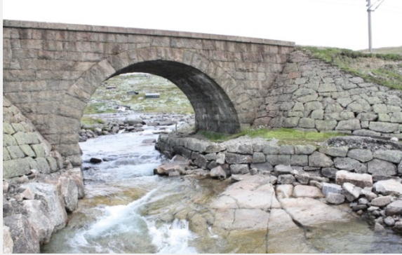
Element nr. 1 Bru over Finseåa
