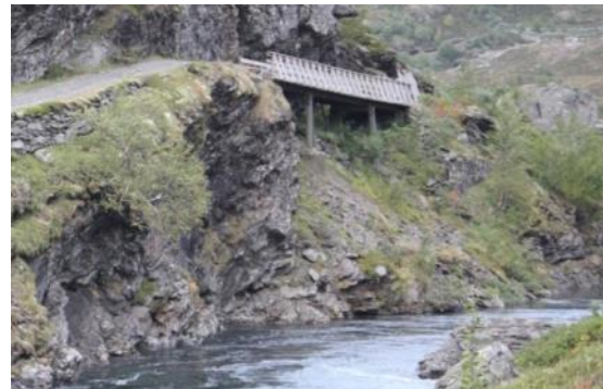
Th: Bru til erstatning av utrasa mur.
