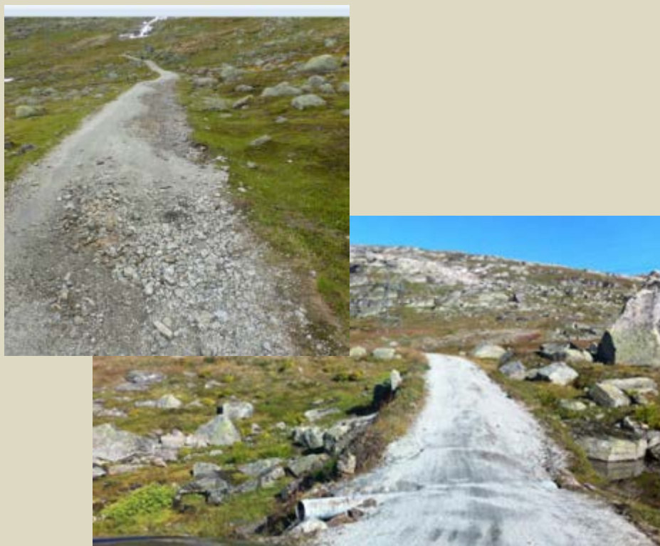
Element nr.4: Frå undergang Norenut - Slirå
