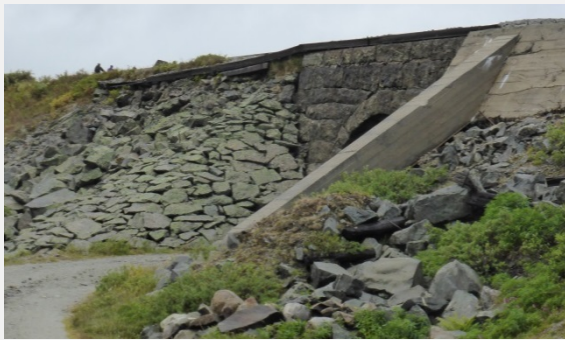
Element nr. 3 Undergang Finsesvingen
