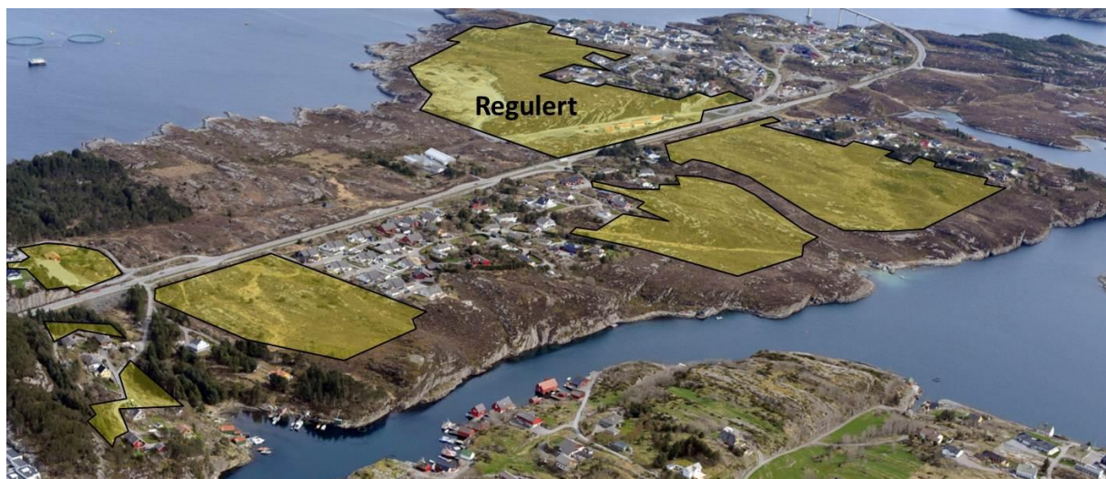
Ny bustadutbygging i delområda 1 og 2: Rongesund, Ormhilleren, Storevarden og Raudhammaren + Austmarka og Aseta (d.v.s. område sør for Arseta), sett frå nordvest. Eit område aust for Fv 561 er regulert til bustader, som utviding av eksisterande felt.
