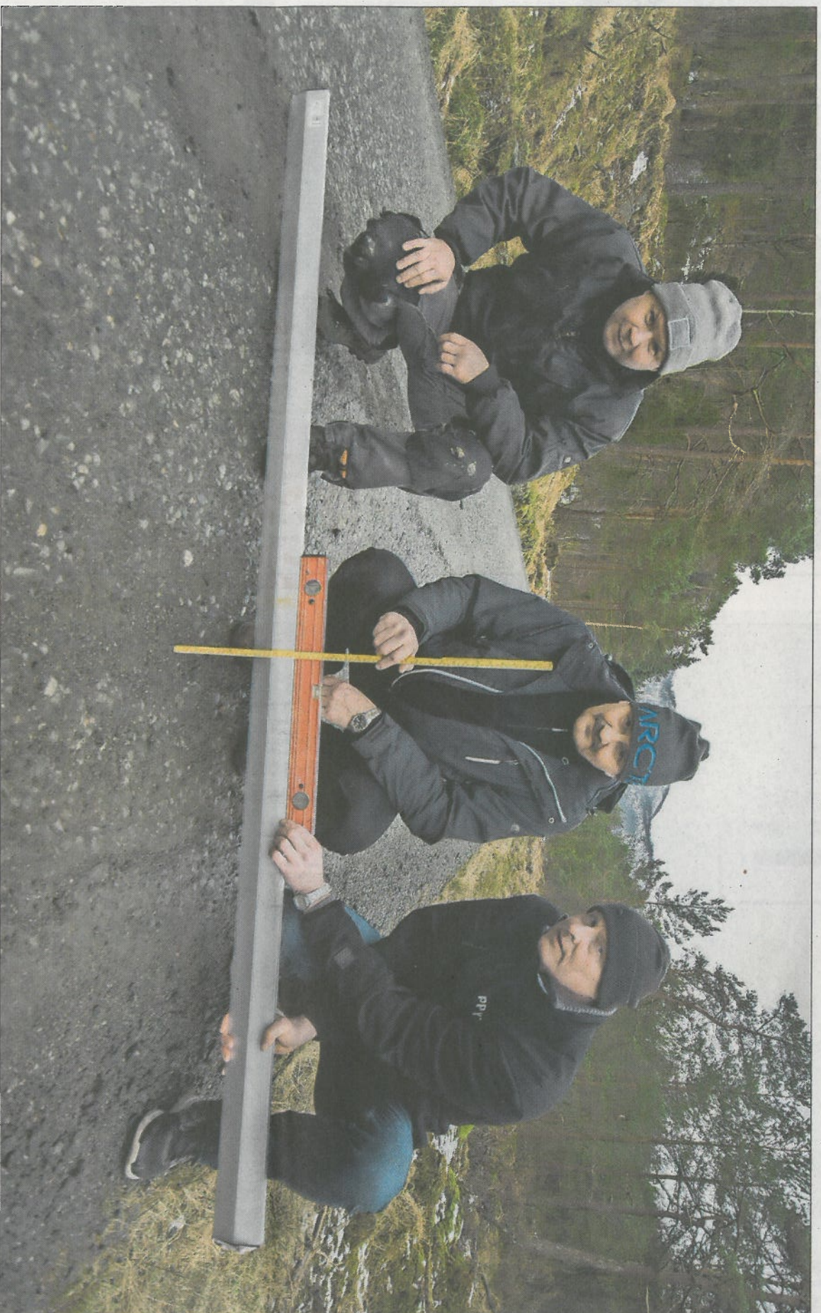
Tore Flyddal (t.v.), Bjarne Hornenes og Jan Molnes krev at Hordaland fylkeskommune tek grep for å få fylkesvegen mellom Etne og Skånøvik i betre stand. Her måler dei 20 centimeter differanse mellom spora ved sida av vegen og midtpunktet av vegen.
