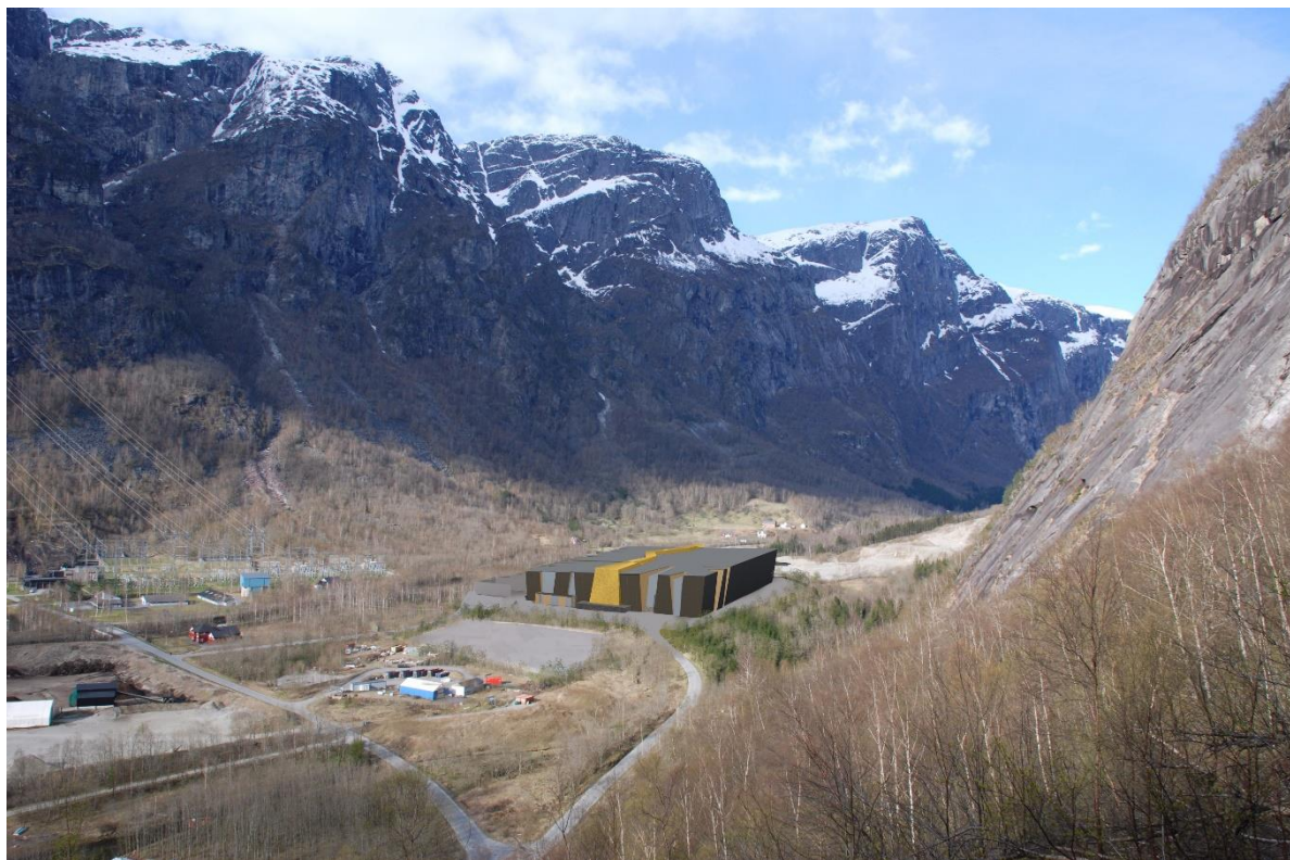
Figur 9-2 Omformerstasjon og koblingsanlegg i Sima med kabel (ikke detaljprosjektert løsning, kun for illustrasjon)
