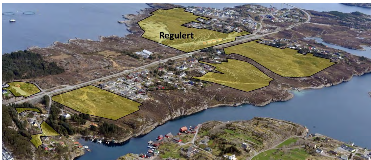
Ny bustadutbygging i delområda 1 og 2: Rongesund, Ormhilleren, Storevarden og Raudhammaren + Austmarka og Aseta (d.v.s. områda sør for Arseta), sett frå nordvest. Eit område aust for Fv 561 er regulert til bustader, som utviding av eksisterande felt.
