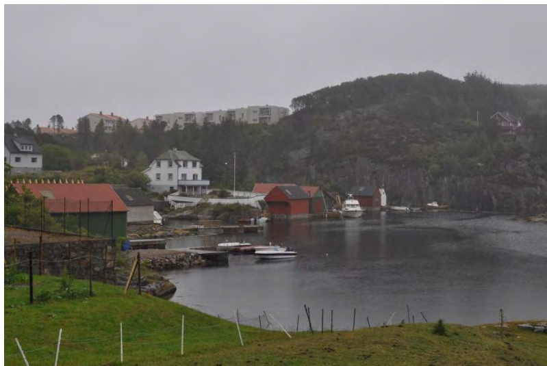
Nye leilighetsbygg ved Rong senter i bakgrunnen, sett frå Skitvika. (Foto: Rambøll)
