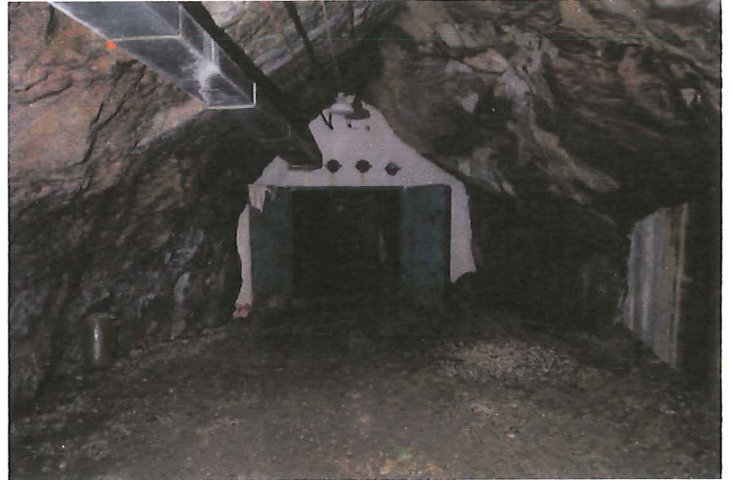
Materiellplass mot sluse. Foto: Leif Anker, Forsvarsbygg
