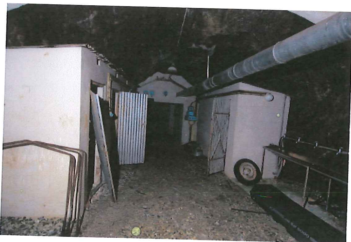
Forhall mot sluse. Foto: Leif Anker, Forsvarsbygg
