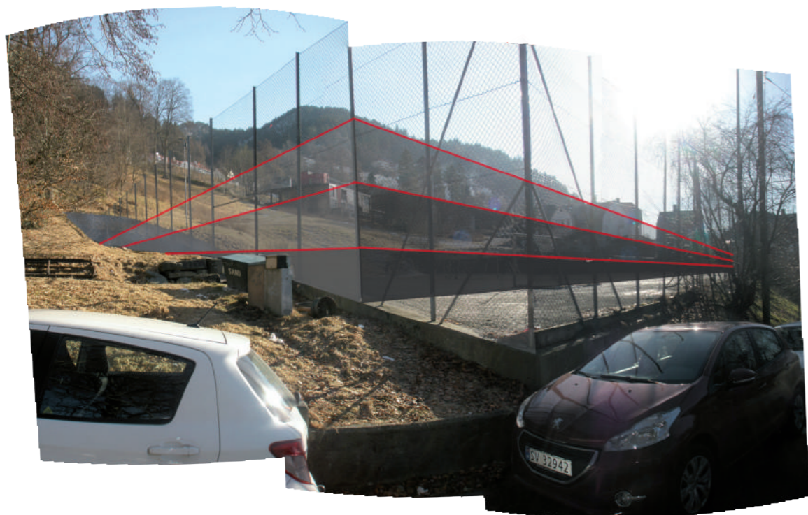
Heving av mulebanens spilleflate, og flytting ca. 3 meter inn i terrenget bak
