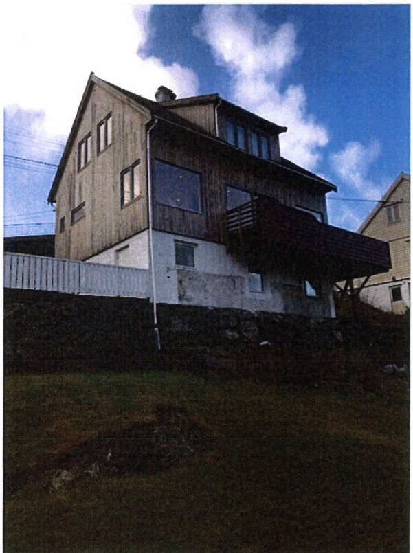
nordøst (eksisterende altan)
