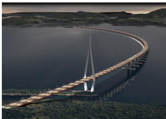
K7-1 endeforankra flytebru, K8-1, (venstre), og sideforankra flytebru, illustrasjon Sv
