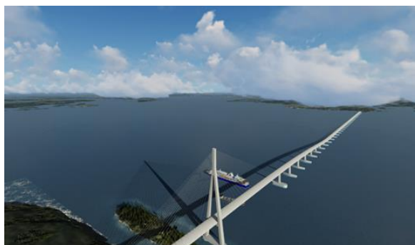
K7-1 endeforankra flytebru, K8-1, (venstre), og sideforankra flytebru, illustrasjon Sv
