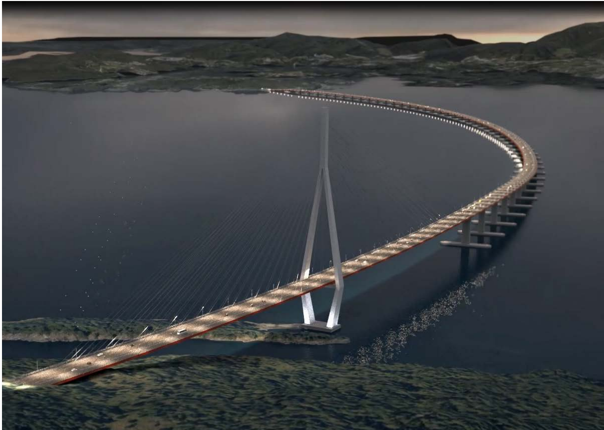
Figur 1-5 Illustrasjon av ny endeforankra flytebry med krumming mot aust og seglingslei i sør.
