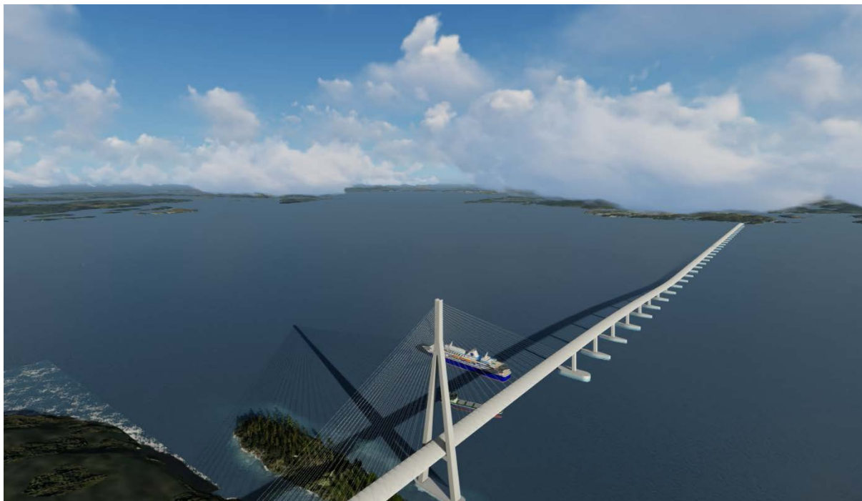
Figur 1-6 Illustrasjon av sideforankra, rett flytebru med seglinge i sør
