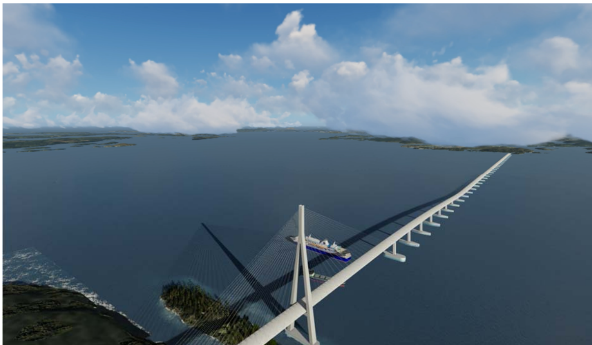
Figur 1-6. Illustrasjon av sideforankra, rett flytebru med seglingslei i sør
