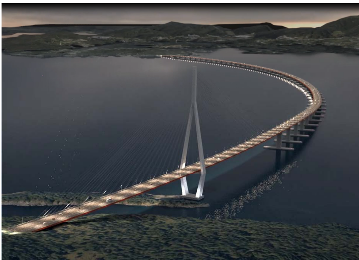
Figur 1-5. Illustrasjon av ny endeforankra flytebry med krumming mot aust og seglingslei i sør.
