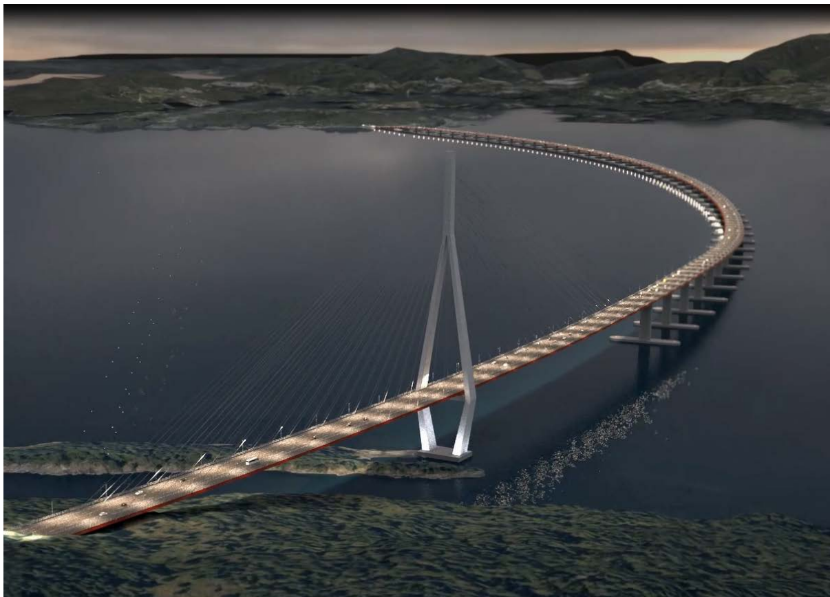
Figur 1-4 Illustrasjon av ny endeforankra flytebrý med krumming mot aust og seglingslei i sør.
